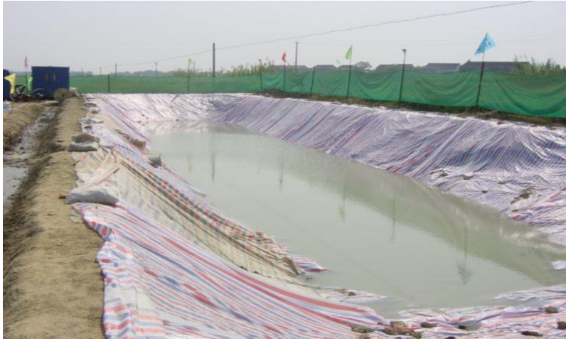
图 4.8 开挖泥浆坑
