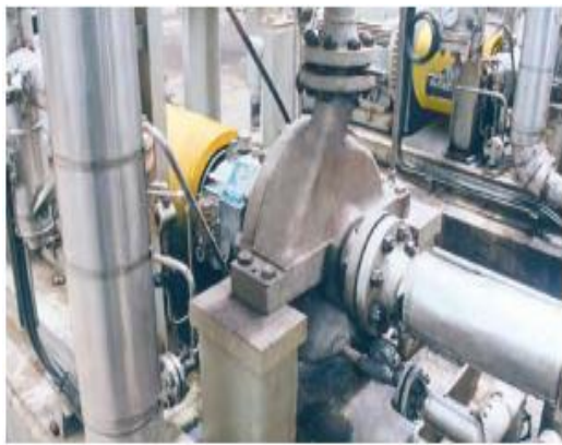
图 3.29 OHHL 泵示意图
